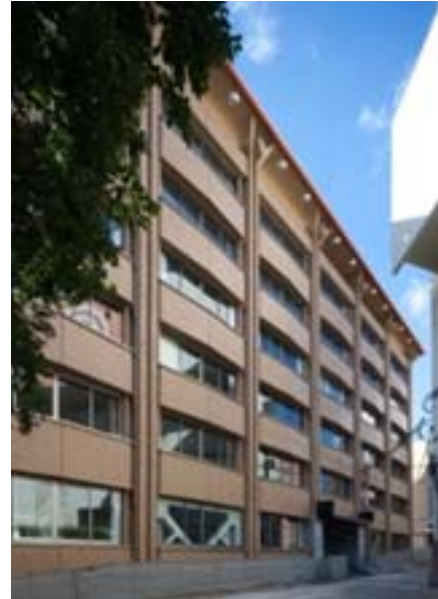
D館外観（北側）
