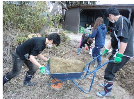
(写真) 被災地での瓦礫撤去作業
