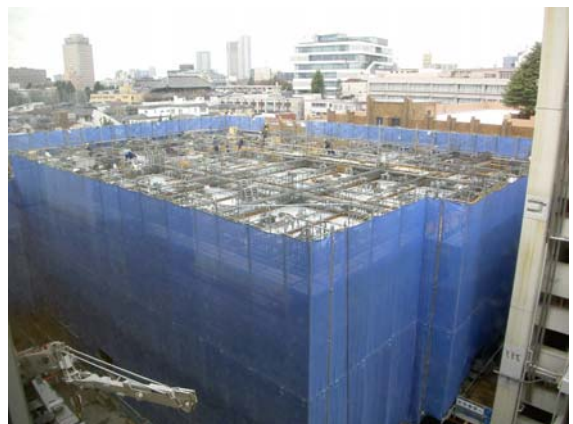
西棟躯体工事
