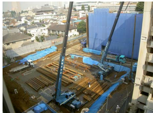
西棟建築工事（山留工事）
