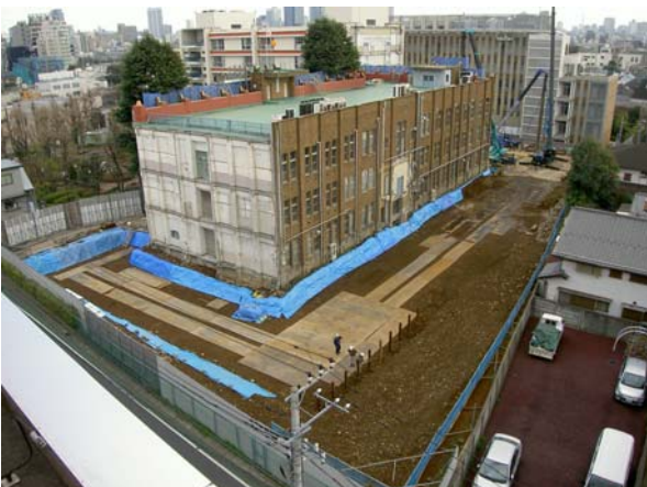
A館北側一部、B館解体跡
